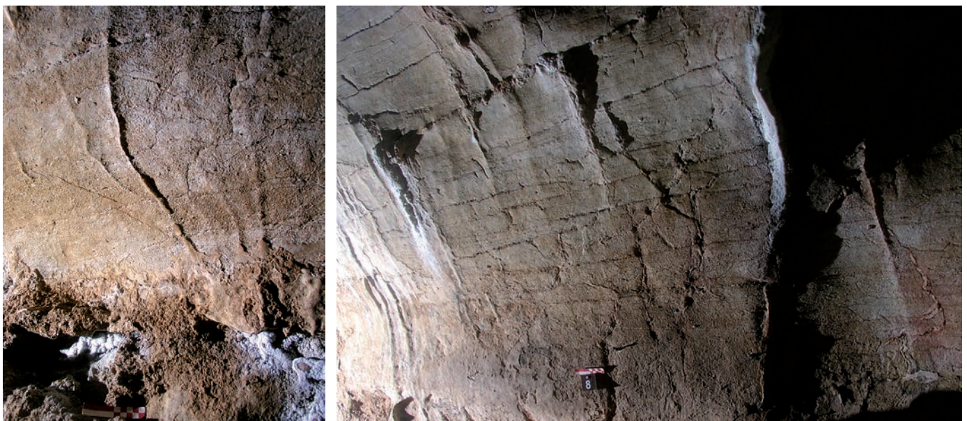
Figure 20 : Les draperies et filets de calcite protègent un temps la paroi de la condensation-corrosion. Les bandes verticales de calcaire en relief attestent le retrait de la paroi, sous l'effet des suintements corrosifs, grotte d'Azé, Saône-et-Loire. Clichés J.-Y. Bigot. The calcite curtains and lines are temporarily protecting the wall from condensation-corrosion. The vertical stripes of limestone show the wall retreat originating from corrosive seepage, grotte d'Azé, France.
